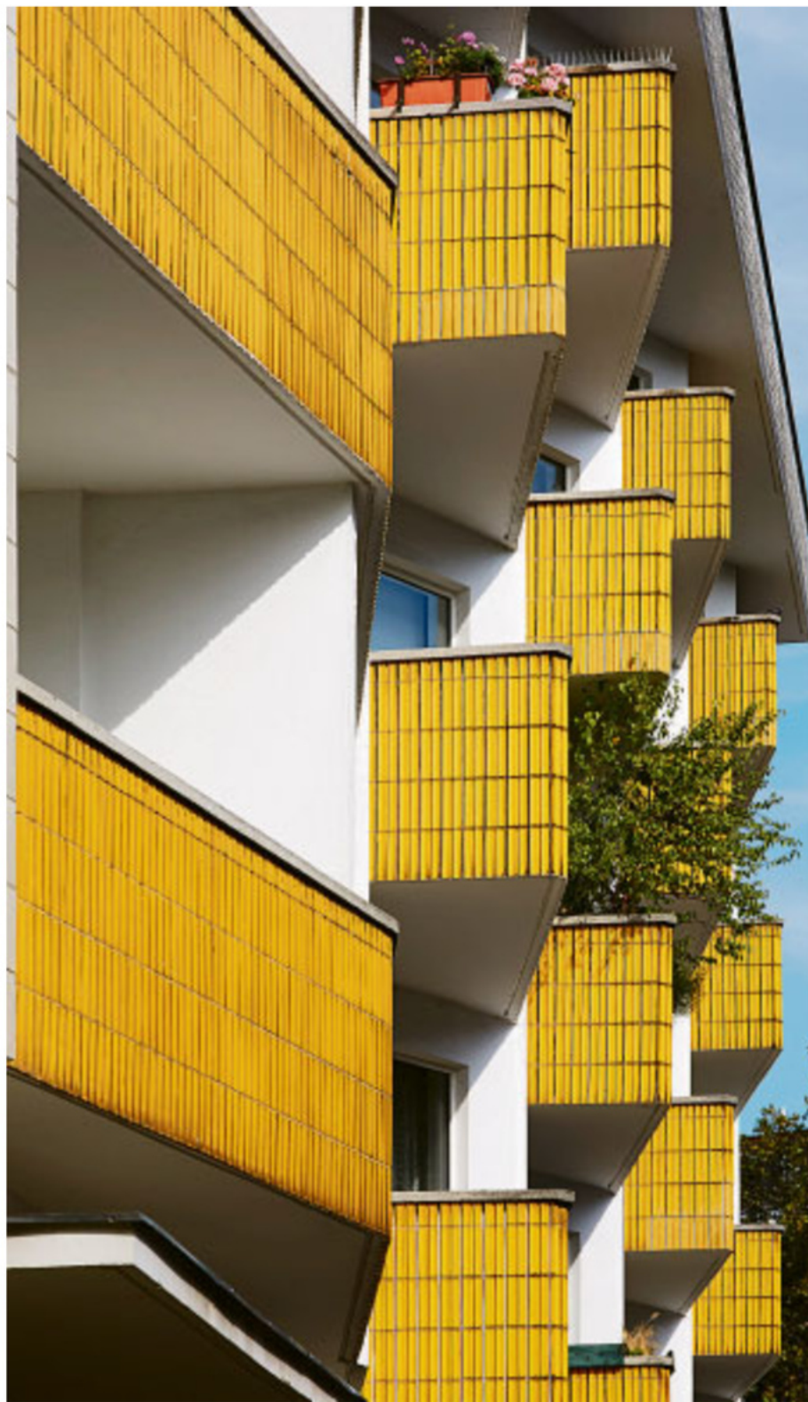
Balkone wie Goldbarren: Wohn- und Geschäftshaus im Nordend
