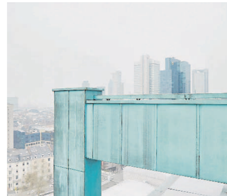
Ein Detail am Hochhaus der Schweizer-National Versicherung.
