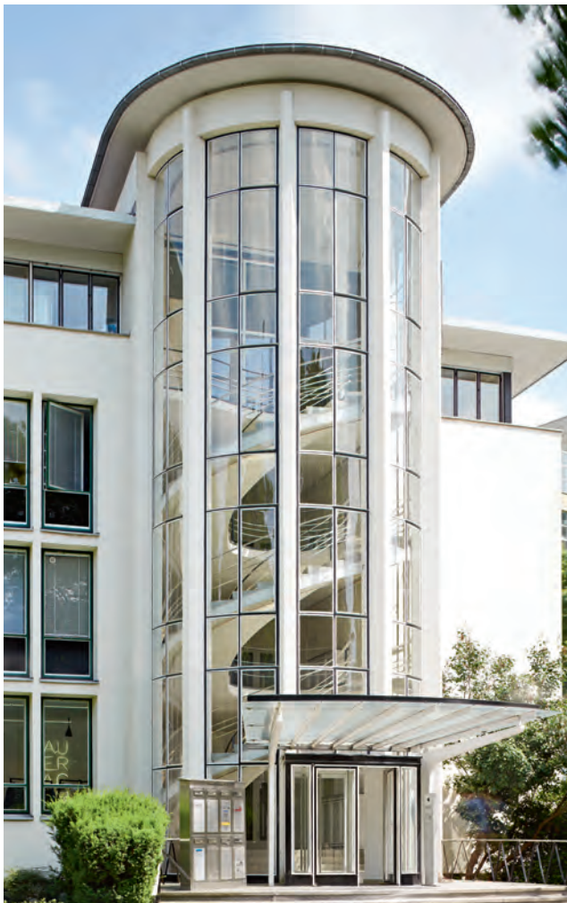
Senckenberganlage 10–12 (l.), Treppe im Juniorhaus (r.)
